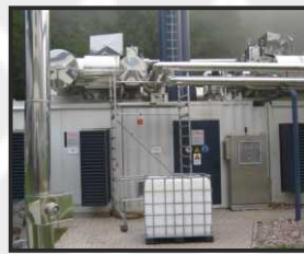
Abgaswärmetauscher, abgas- und wasserseitig
